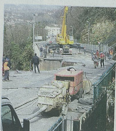
I lavori sul viadotto
